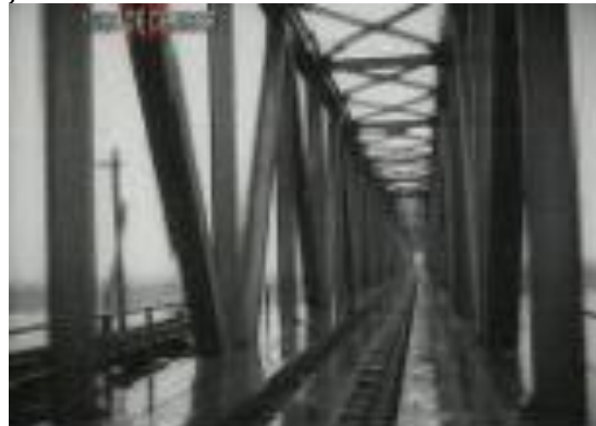
Az 1955-ben újjáépült komáromi híd
