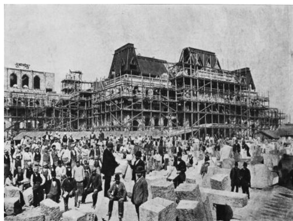
A parlament épülete építés közben 25
